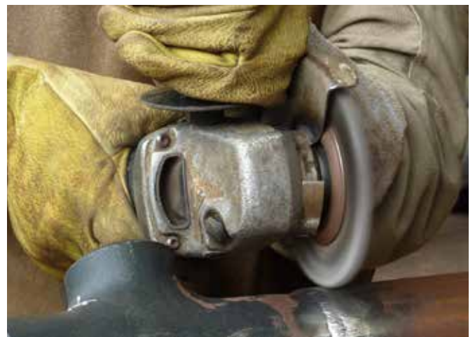
Очистка сварных швов с помощью проволочных щеток
