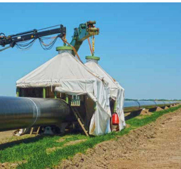
Площадка для строительства трубопроводов
